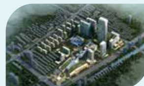
Nanjing AVIC City of technology 南京科技中航城
