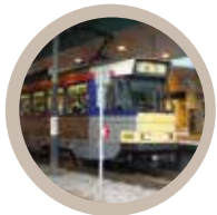
● Tuen Mun LRT Phase 2 - Detailed Design and Site Supervision, Hong Kong 香港屯门轻轨二期详细设计与工地监管
